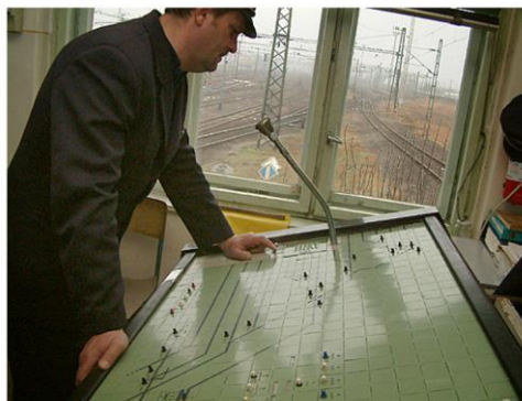
Ha tolatás közben a váltó(váltókati) nem a tolatásvezető állítja: a váltót állító dolgozó a kért vágányút beállítása után köteles a tolatásvezető felé a tolatás megkezdéséhez, illetve folytatásához szükséges jelzést adni.
